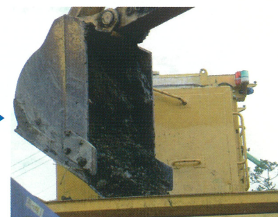
②流し込んだ土と石灰を混ぜ合わせる
