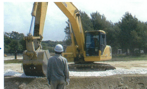
②散布した石灰を敷き均しする
