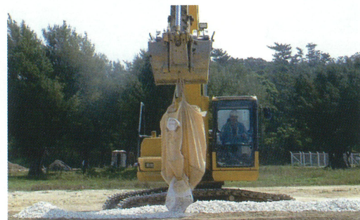
①土に直接、石灰を散布
