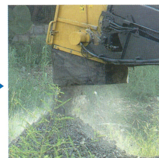
③混合された土を排出
