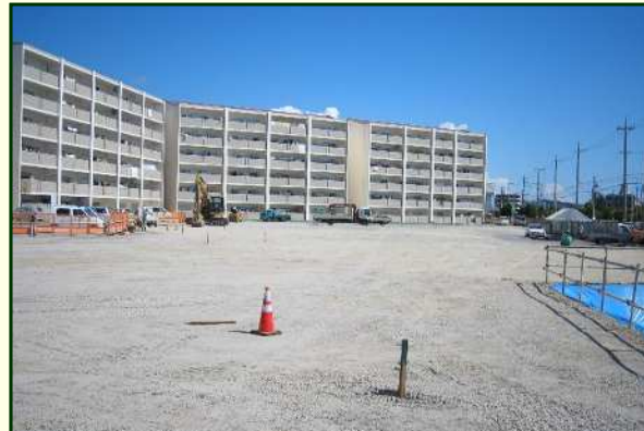
県営泡瀬団地立替工事
