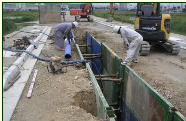
北谷町桑江下水管新設工事
