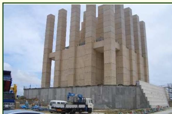
那覇埠頭空港線三重城側換気搭外工事
