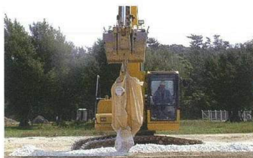
①土に直接、石灰を散布
