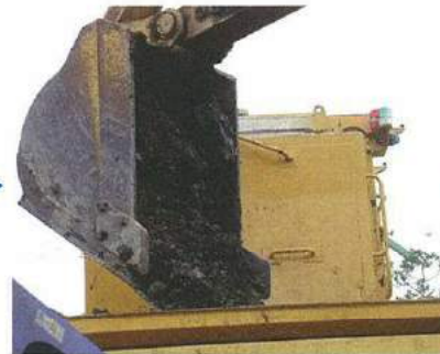
②流し込んだ土と石灰を混ぜ合わせる
