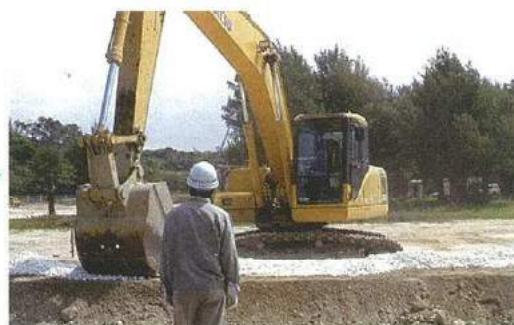
②散布した石灰を敷き均しする
