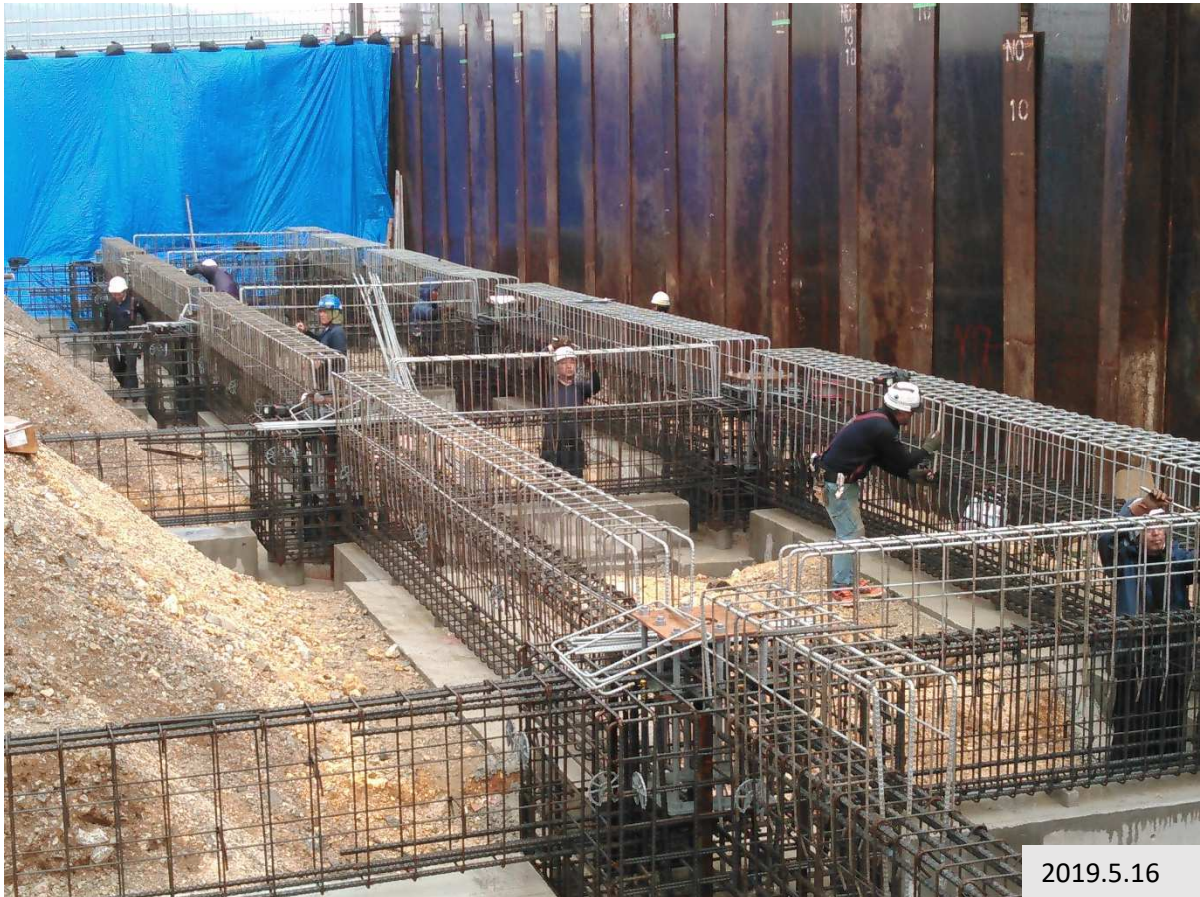
本部港立体駐車場 基礎部分(沖縄県 本部町)
