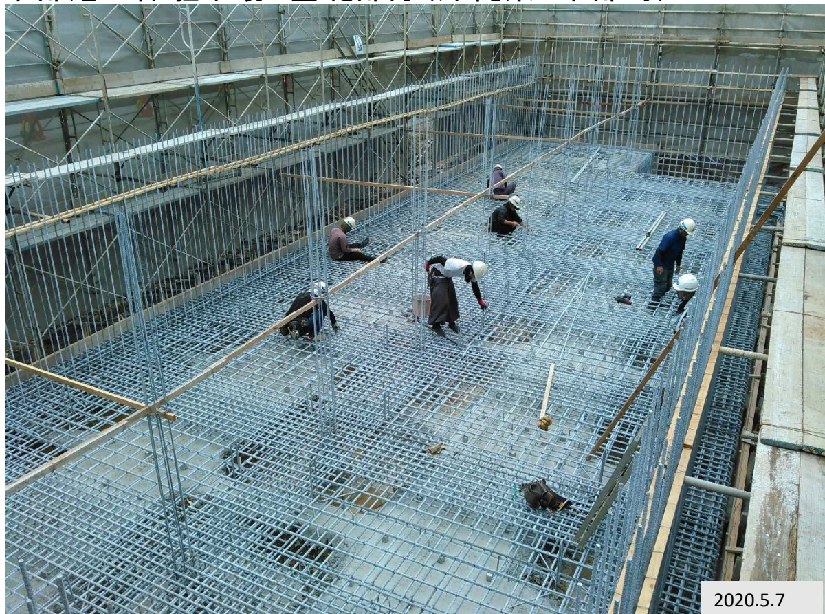
許田地区交通安全対策工事 浄化槽(沖縄県 名護市)
